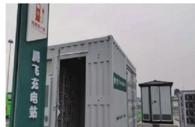
陕西咸阳机场光储充760V200Ah*6150KW/1.4MWh
